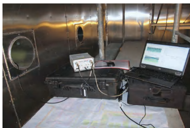
安装过程中的磁场测量
